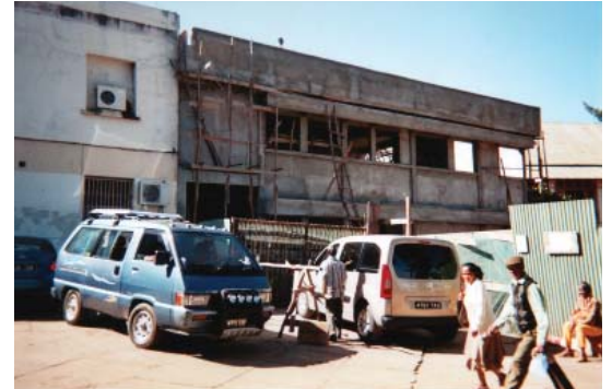
Travaux d'extension du bloc opératoire
